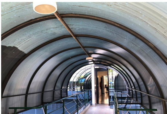
Figura 3: Demonstração da parte interna da passarela.
